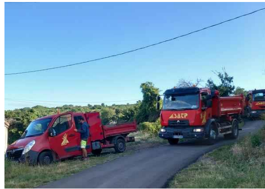
Travaux de réfection de la chaussée sur les routes communales de Largelas, et la route de la Mûre.
