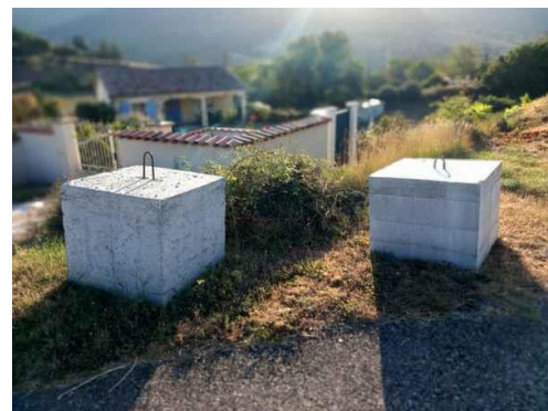
Installation de deux blocs de béton de protection à l'angle de la route de Rabayas.
