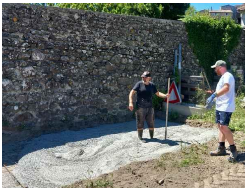
Réalisation d'une plateforme pour le stockage des matériaux au local technique (sable, gravier...).
