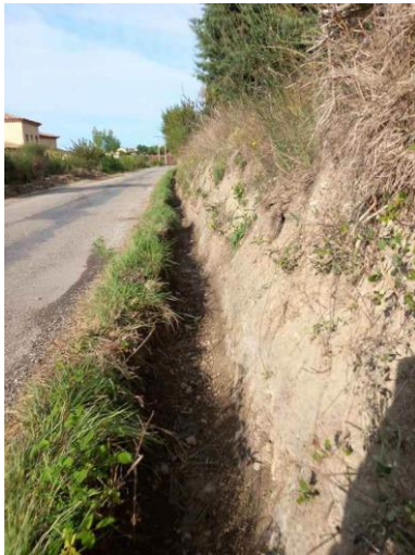
Curage des fossés Route de La Mûre, et celle des 4 soleils.
