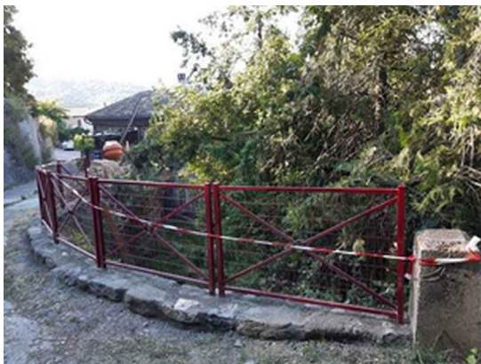
Mise en place d'une barrière de protection, rue du Lavoir.
