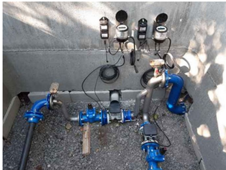
Pose de débitmètres dans la chambre de réunion des sources du Réviscou et de la Fare.
