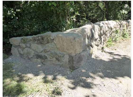
Réparation du pont des Roures.
