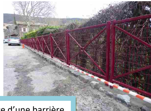
Mise en place d'une barrière rue des écoles
