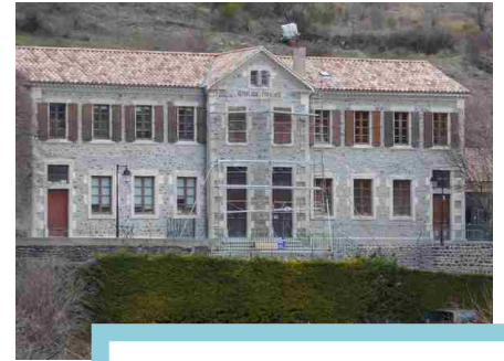
Restauration des façades de la mairie
