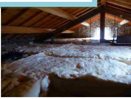
Travaux d'isolation de la mairie
