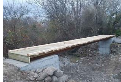
Passage de la Rivière L'Éguille par une passerelle.
