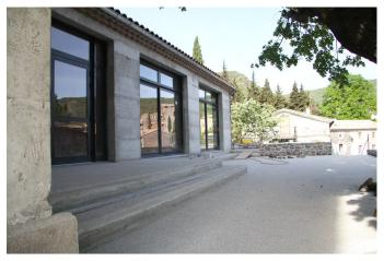
Les aménagements sont exécutés : escalier cantine, terrasse et marches en béton lavé par l'entreprise Sévenier Poutrel (l'escalier d'accès de la porte Nord a été réalisé en régie)
