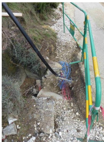
Travaux d'extension du réseau électrique et rénovation de la conduite d'eau quartier du Serre Pointu.
