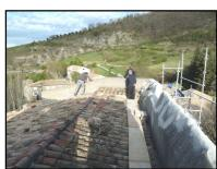
Les travaux de remise en état de la toiture du château église, pour un montant de l'ordre de 14 000 euros, sont en voie d'achèvement. Après la réfection d'une partie de la toiture au niveau étanchéité, c'est le remplacement de la zinguerie qui est actuellement en cours. L'ensemble des travaux a été confié à l'entreprise locale Nils Payet-Descombes.
